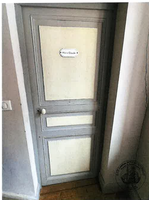
1 er étage : Chambre à gauche en sortie d'escalier
