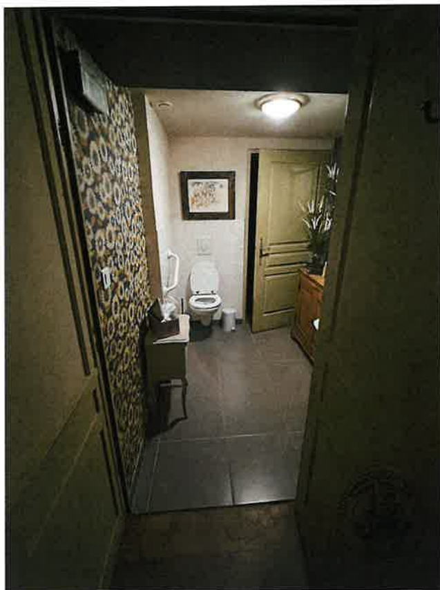
WC 4,12 m 2 : un W.C. suspendu et un lavabo, carrelage au sol, peinture et tapisserie aux murs. Peinture au plafond.
