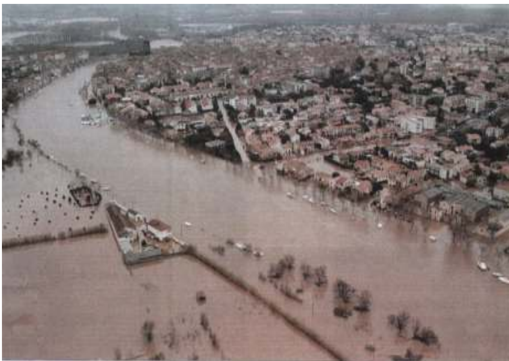
Agde – Crue de 1997 – Crédit photographique : DDE 34
